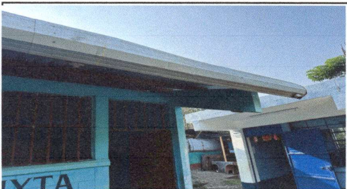
Foto 3: sustitucion de canal de metal
