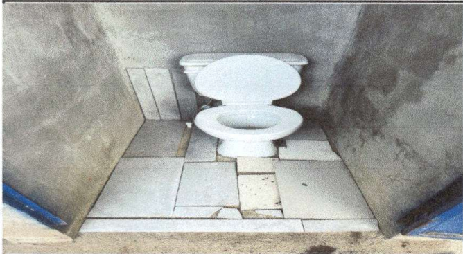
Foto 1: sustitucion de azulejo
