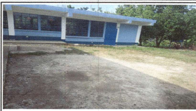
Foto 2: sustitucion de piso de torta de concreto
