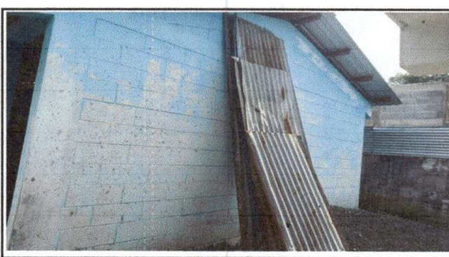
Foto 6: pintura de muros exteriores e interiores
