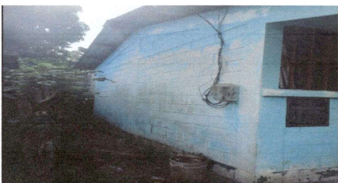
Foto 5: pintura de muros exteriores e interiores
